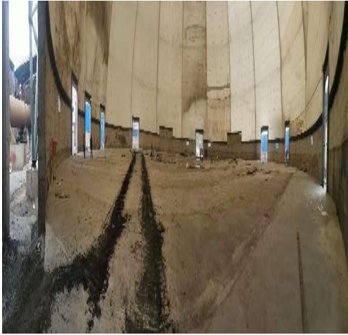
1#危废库地面混凝土浇筑完成
