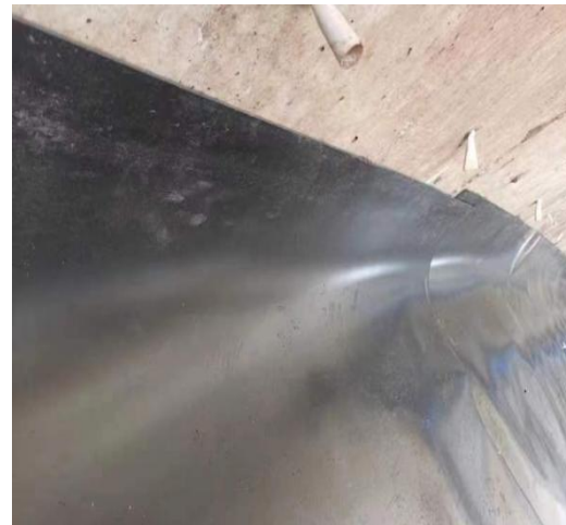
1#危废库土工膜上浇筑混凝土层
