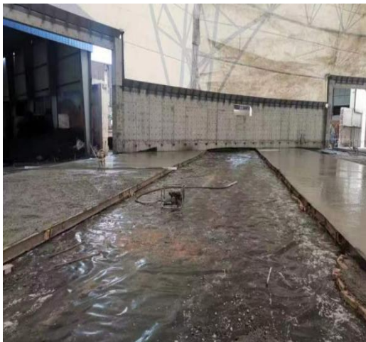
1#危废库土工膜上浇筑混凝土层
