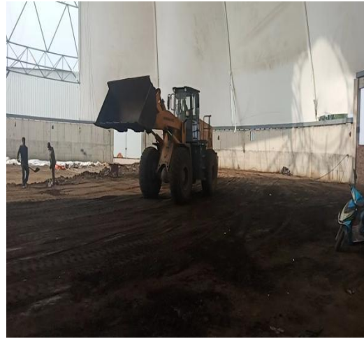
2#危废库地面覆土压实
