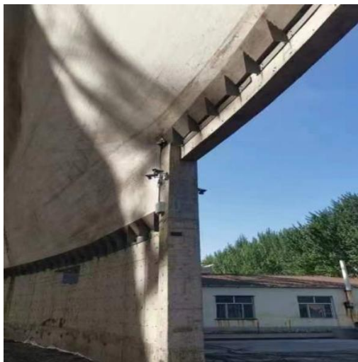
1#危废库监控系统
