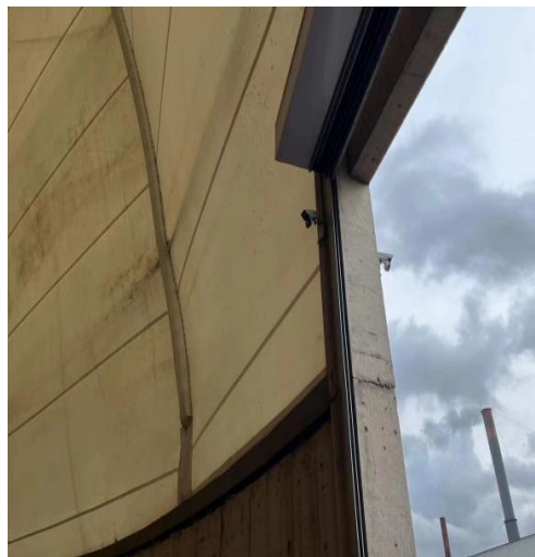
2#危废库监控系统
