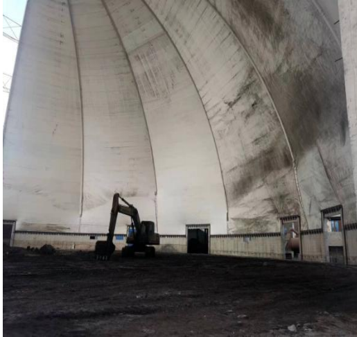
在原有危废库地面基础上加增垫层
