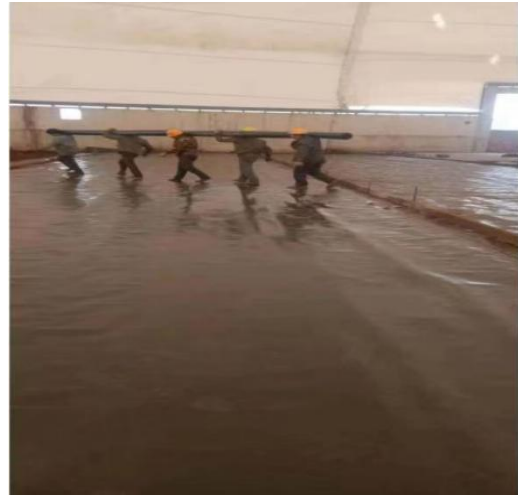
2#危废库库底敷设土工膜
