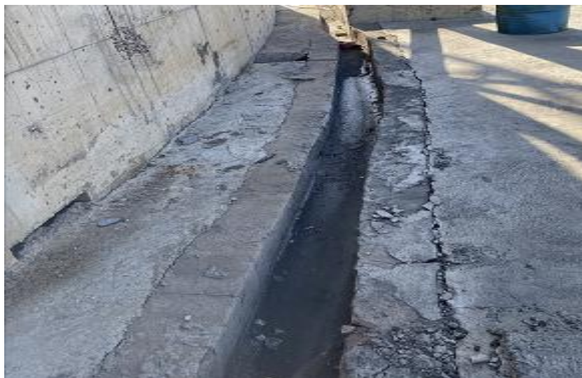
危废库周围的雨水排水沟
