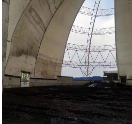
在原有危废库地面基础上加增垫层
