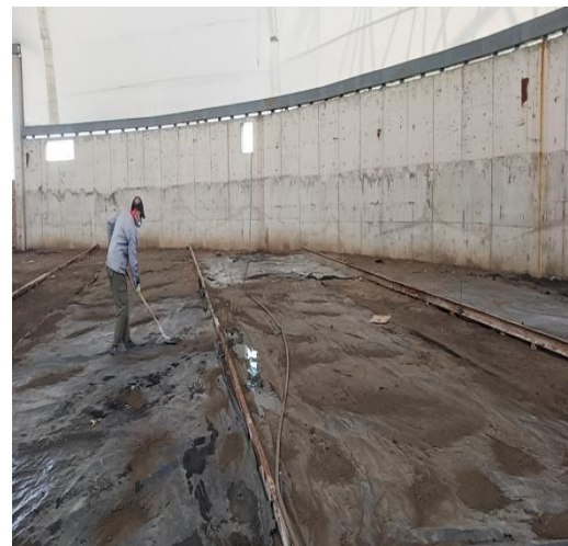
2#危废库土工膜上浇筑混凝土层
